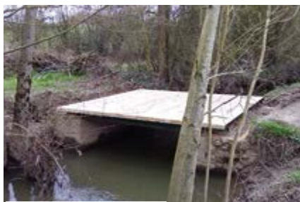
La réalisation d'un pont
