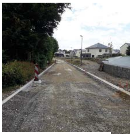
Les voies dédiées aux différents usages voiture, piétons et cycle sont maintenant terminées, les lampadaires mis en place.
