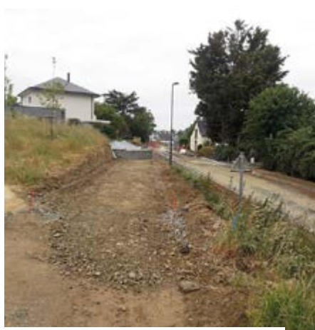
Les travaux de finition : le grenailage de l'enrobé sur certains secteurs, la pose de la signalétique verticale et horizontale ainsi que la pose du mobilier seront réalisés en juillet. Les plantations seront mises en place à l'automne prochain.
