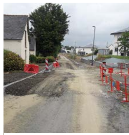
Cette voie tant attendue par les nouveaux habitants des hameaux de la zac du Terre ainsi que les riverains est maintenant sécurisée afin de permettre les déplacements doux sans risque.
