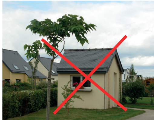
Exemple d'abri de jardin non autorisé : maçonnerie traditionnelle non autorisée
