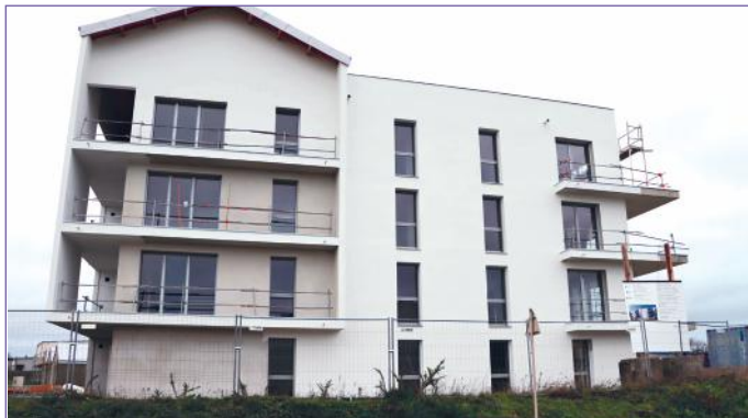
Les nouveaux logements sociaux avenue des Droits de l'Homme
